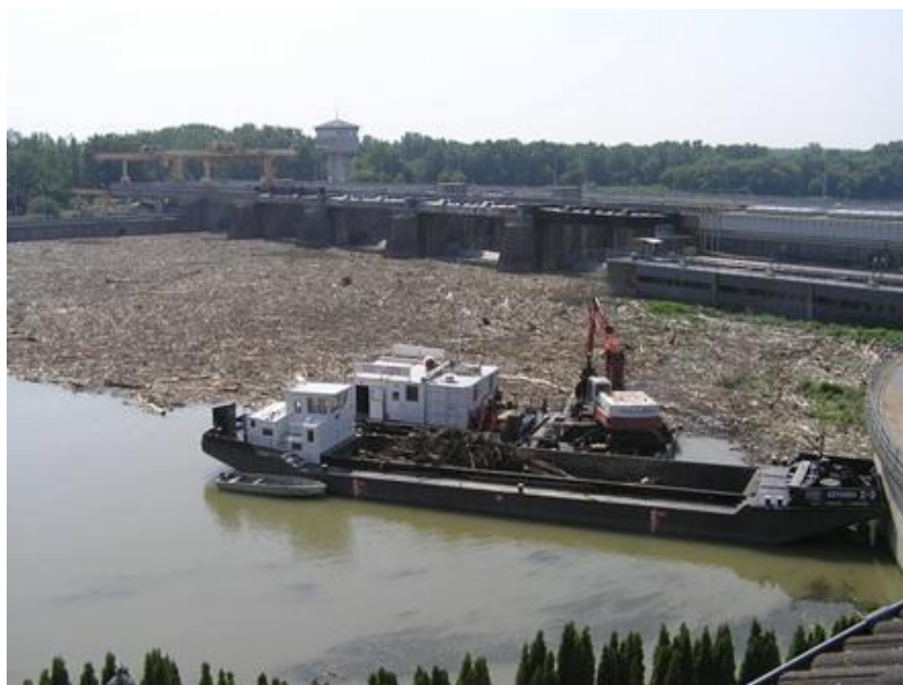
A hulladék kitermelése úszódaruval 300 tonnás uszályra (Forrás: Közép-Tisza- Vidéki Vízügyi Igazgatóság)
